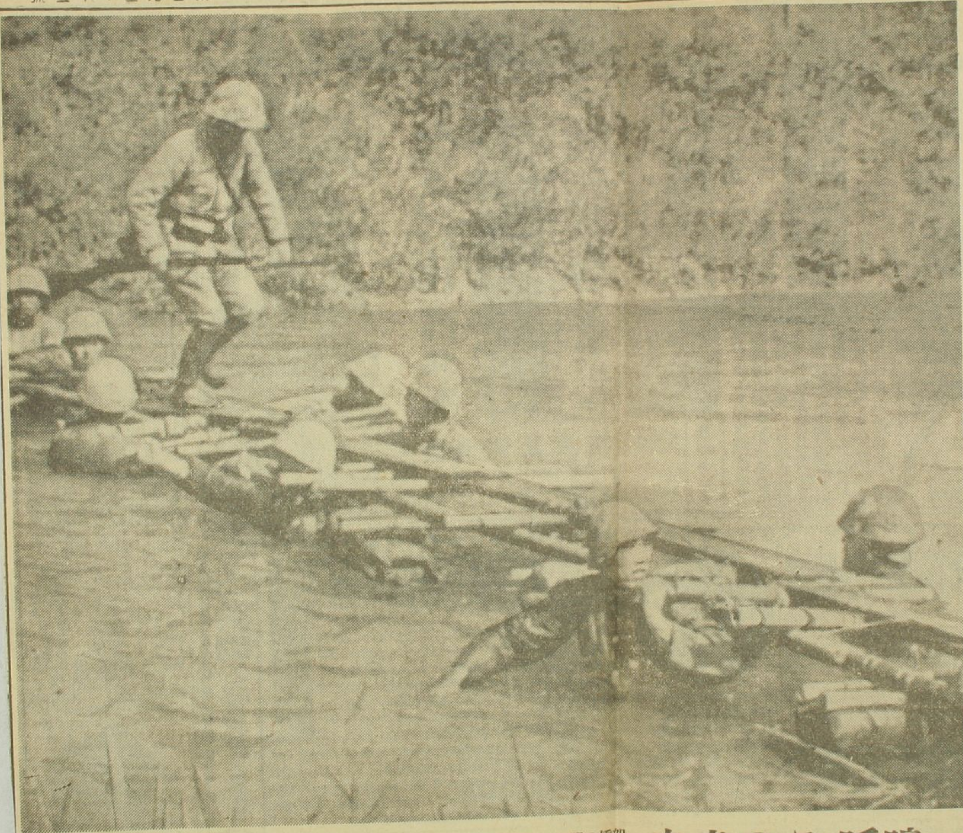
架橋の暇に我工兵隊代つたり友軍歩兵を渡す海上戦線にて 本社特派員撮影—大毎電送
